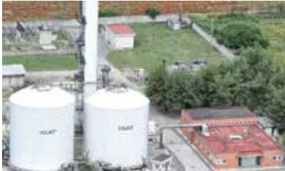
Stabilimento IGAT, Pignataro Maggiore (CE) Italia
