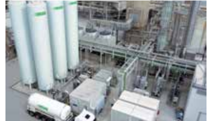
Stabilimento Solvay, Rosignano (LI) Italia
